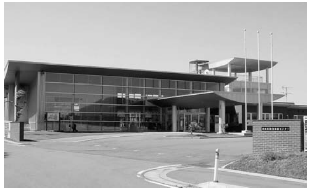
図1 センター本体施設
